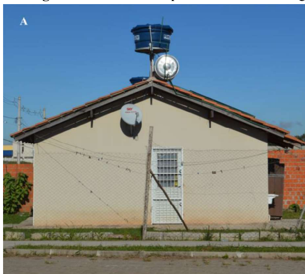
Figura 3. Sistema de aquecimento solar de água: a) vista lateral; b) foto aproximada
