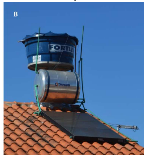
Figura 3. Sistema de aquecimento solar de água: a) vista lateral; b) foto aproximada
